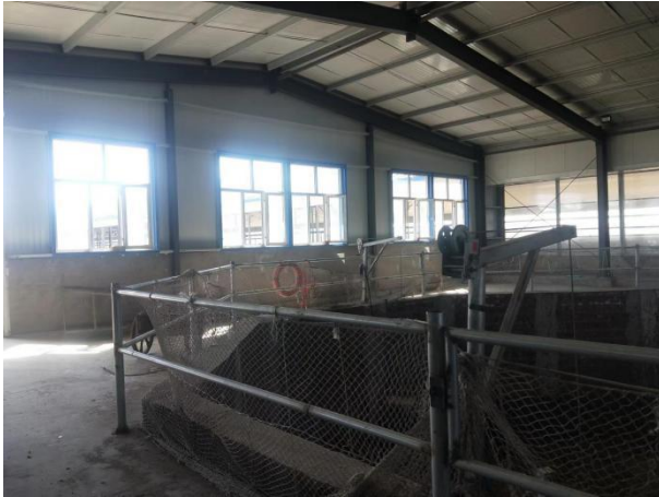
8号-9号全封闭泌乳牛舍西侧联通处
