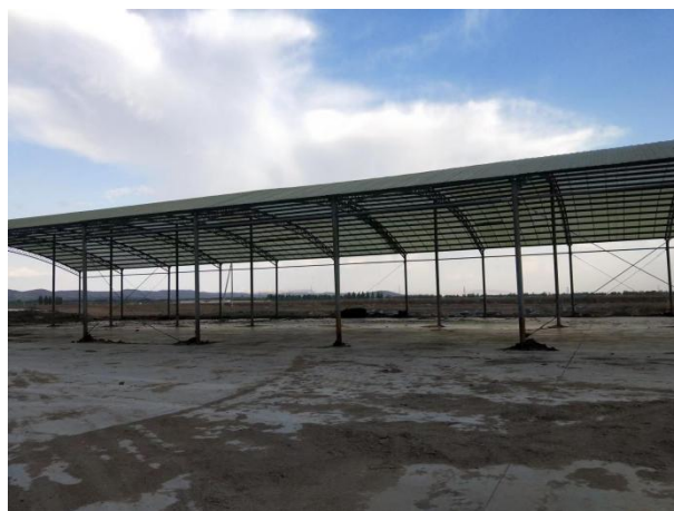
备用粪污堆放场
