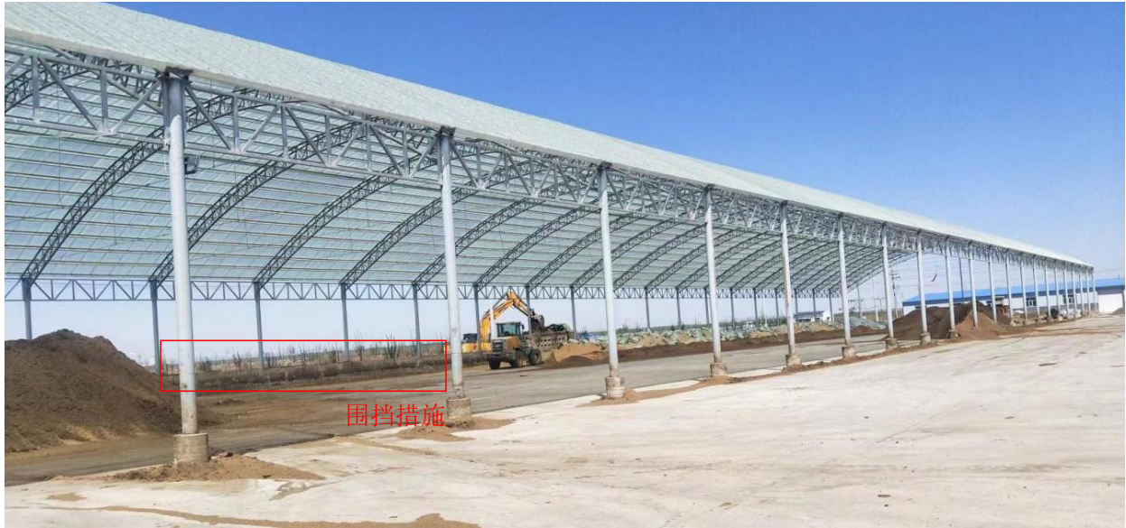
1#粪便堆放场挡雨棚、地面防渗、堆翻机械、围挡措施
