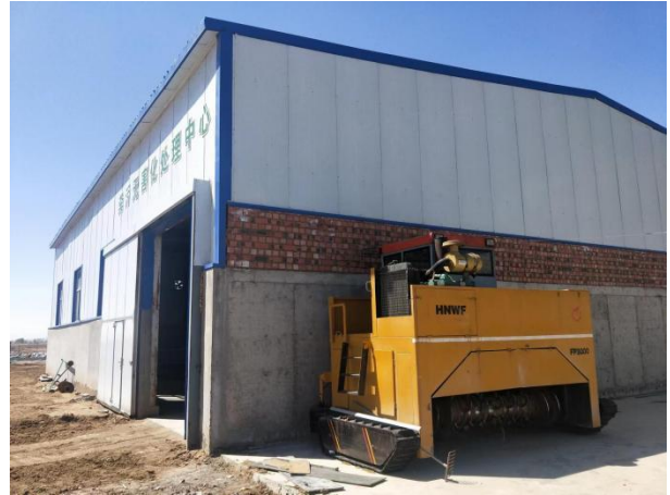
全封闭设备处理间
