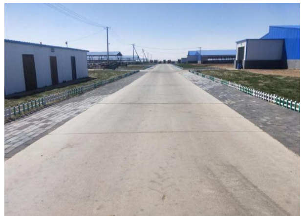
养殖区硬化道路
