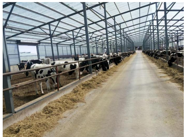
养殖牛舍水泥硬化地面
