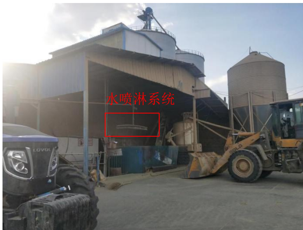
原料投入、TMR 搅拌机及输送
