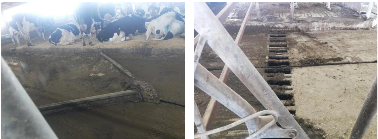
泌乳车间自动刮粪系统及粪污地漏
