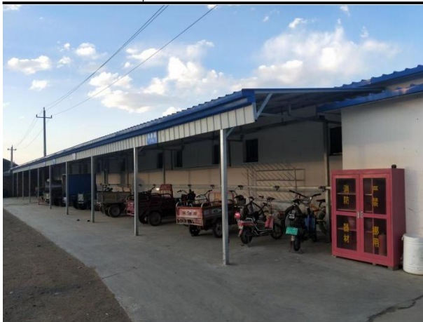
生产区进口设置灭火器等消防措施
